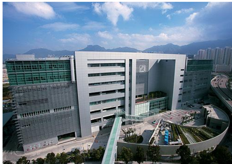
圖 11 機電工程署新總部大樓
