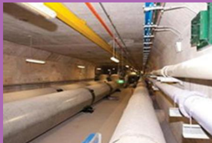
公用設施隧道的內部
